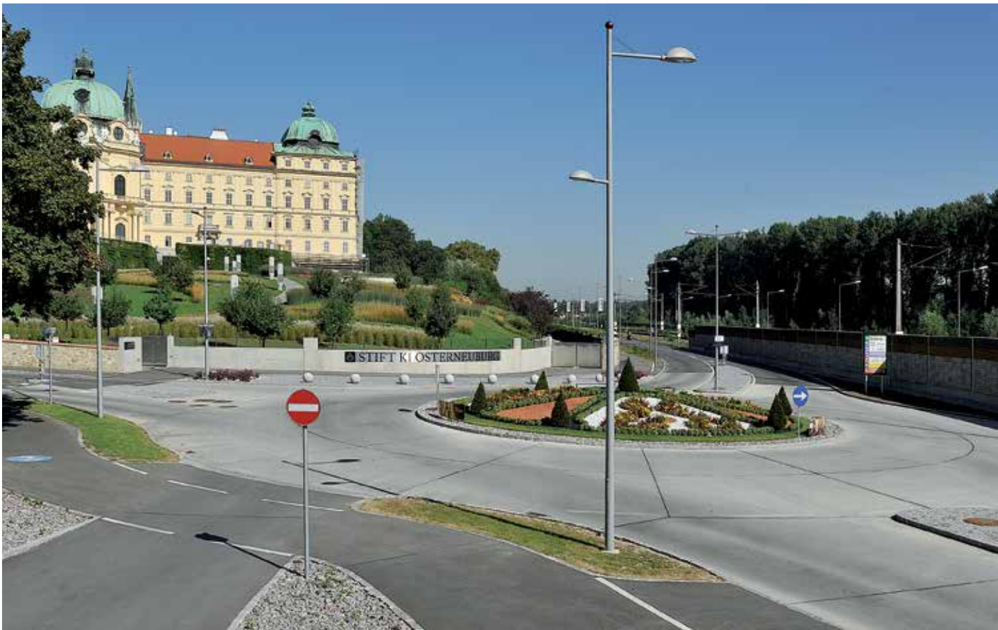
Straßenbau - Klosterneuburg, Niederösterreich
