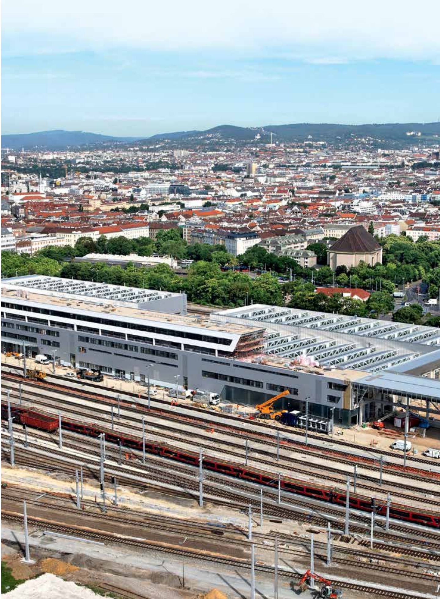
Umbau - Bahnhof Matzleinsdorf, Wien
