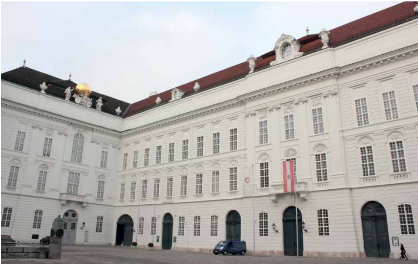
Hofburg, Fassadensanierung, Wien
