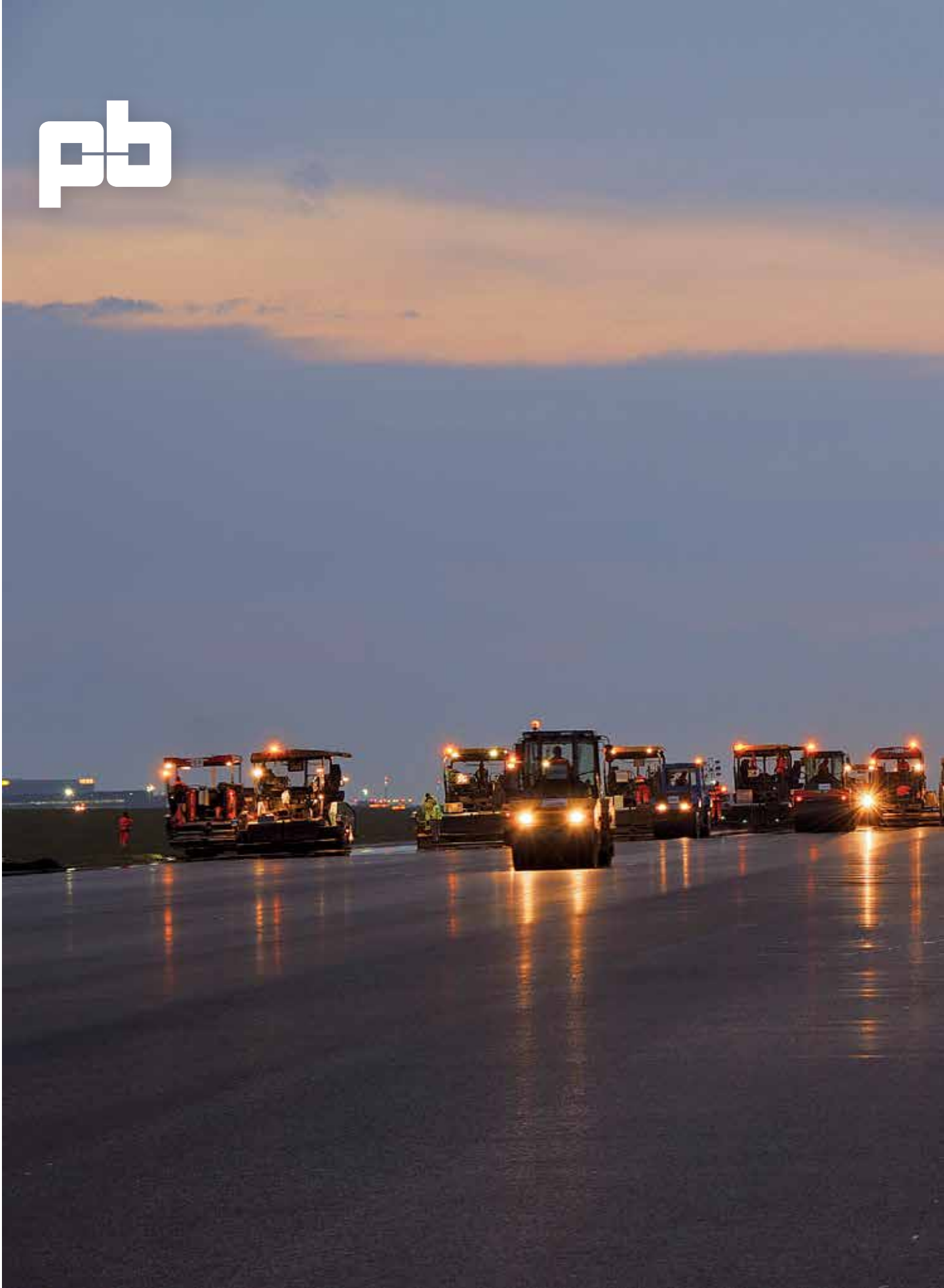
Pistensanierung - Flughafen Wien, Schwechat, Niederösterreich
