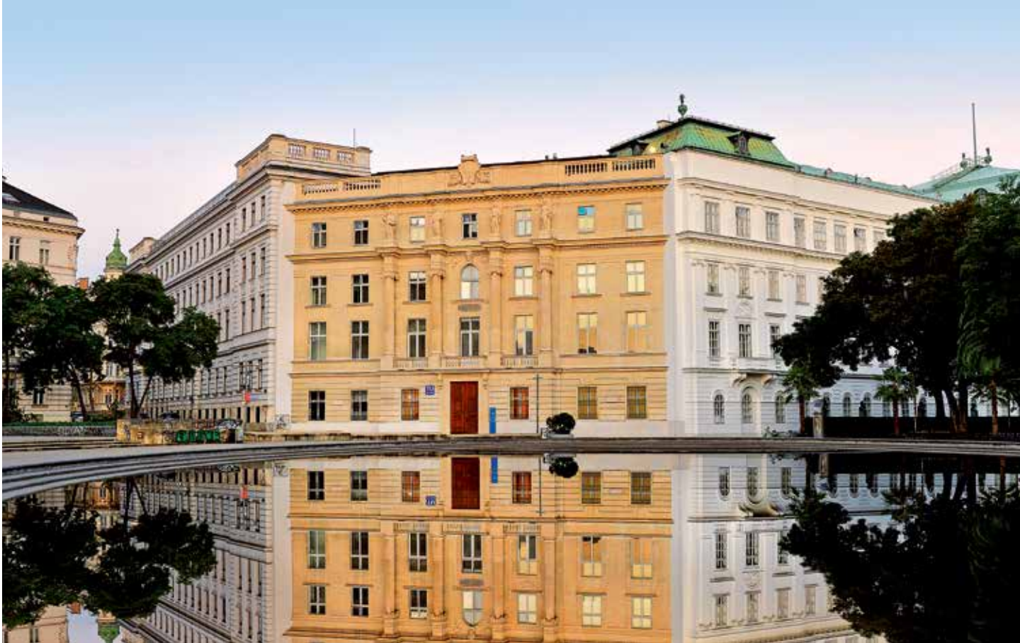
Technische Universität, Fassadensanierung, Wien
