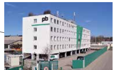
Wien, Büro Wien-Inzersdorf
