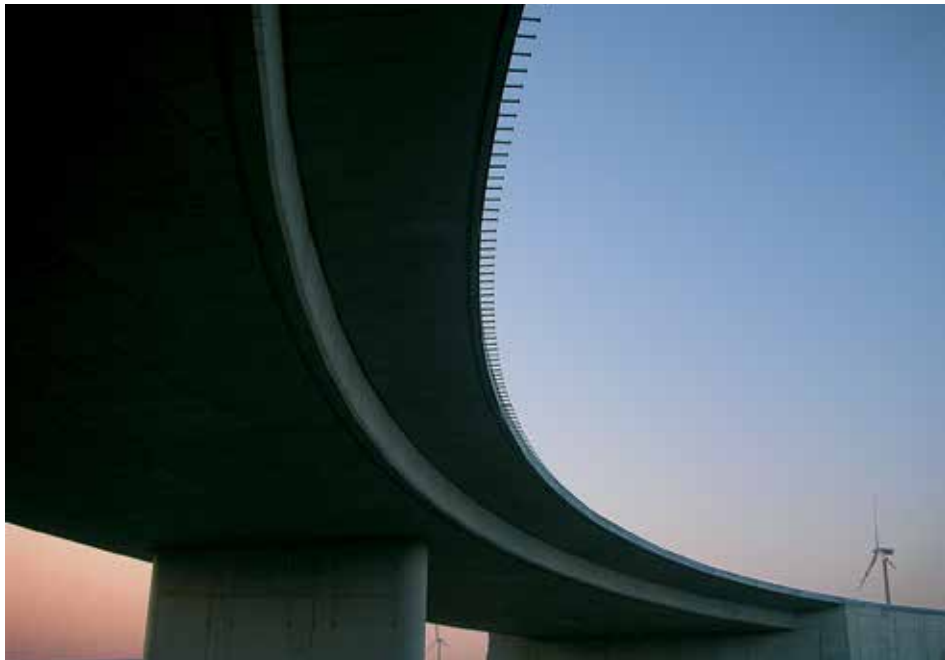
Brücke A6 - Ost
