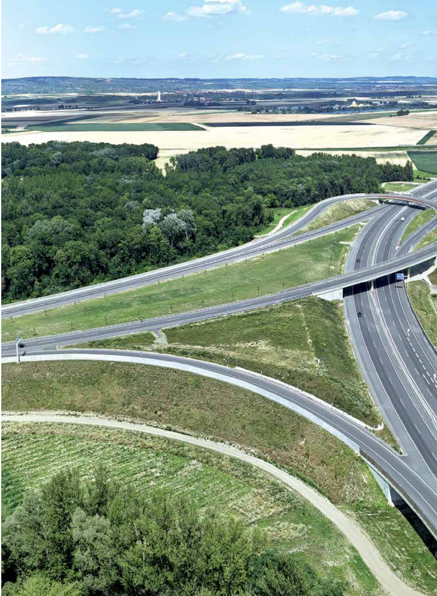
S33 Donaubrücke Traismauer - Rampe Nord, Niederösterreich
