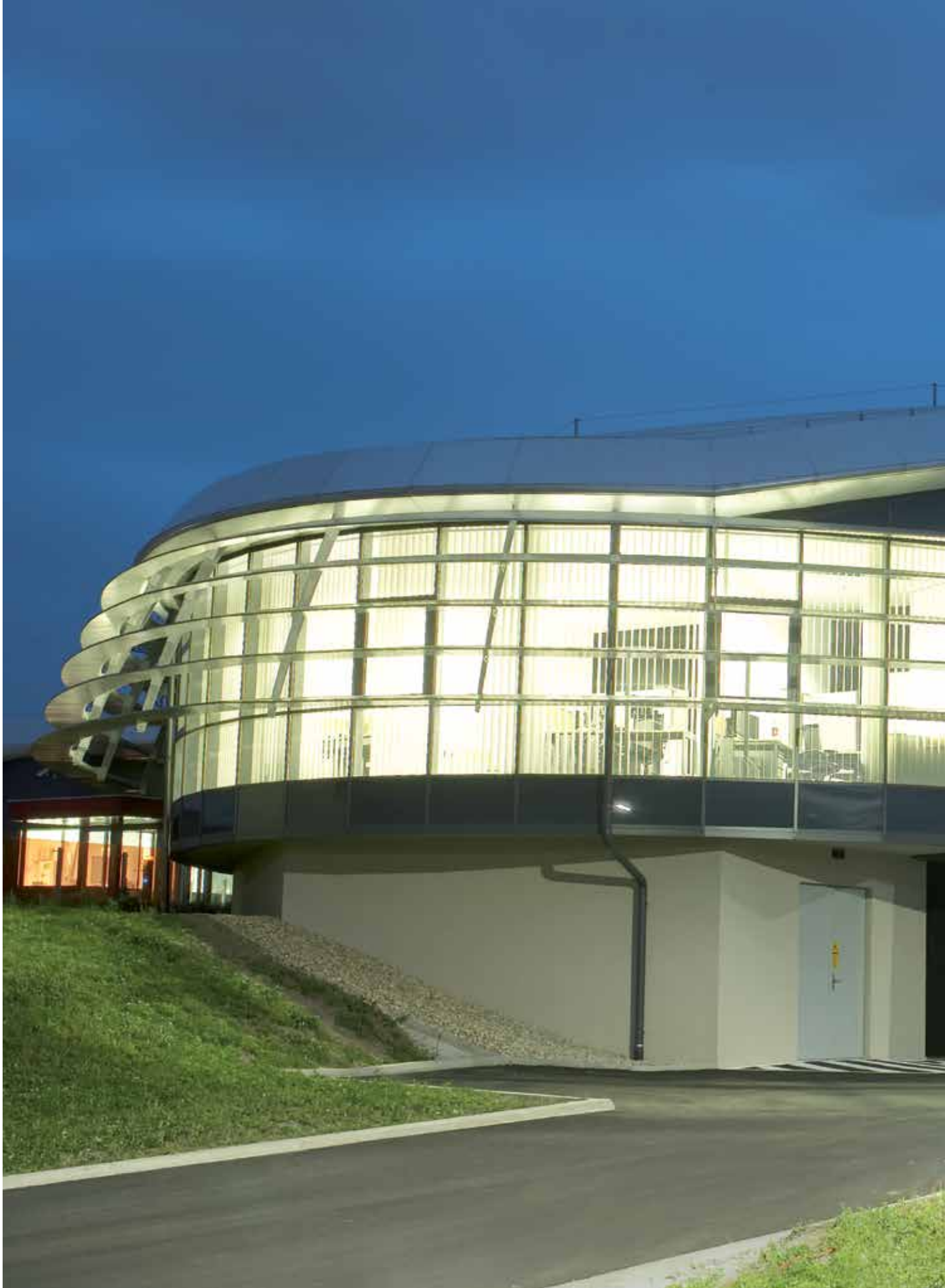
UBH Schaltwarte / Verbund, Wien
