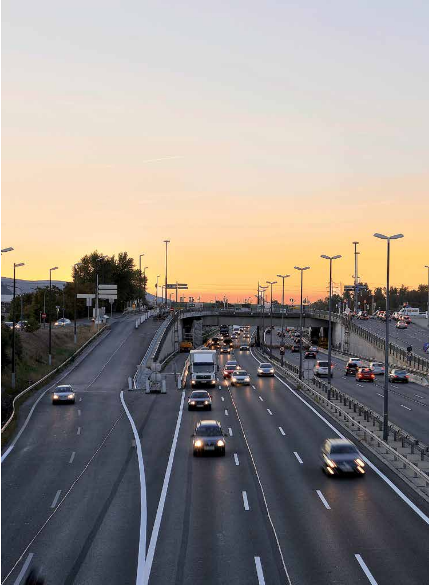
Floridsdorfer Brücke A22, Sanierung, Wien
