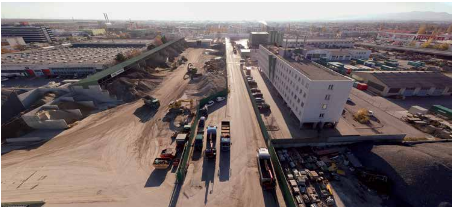
Zentralbauhof Wien-Inzersdorf, Contra Con GesmbH und Bürogebäude
