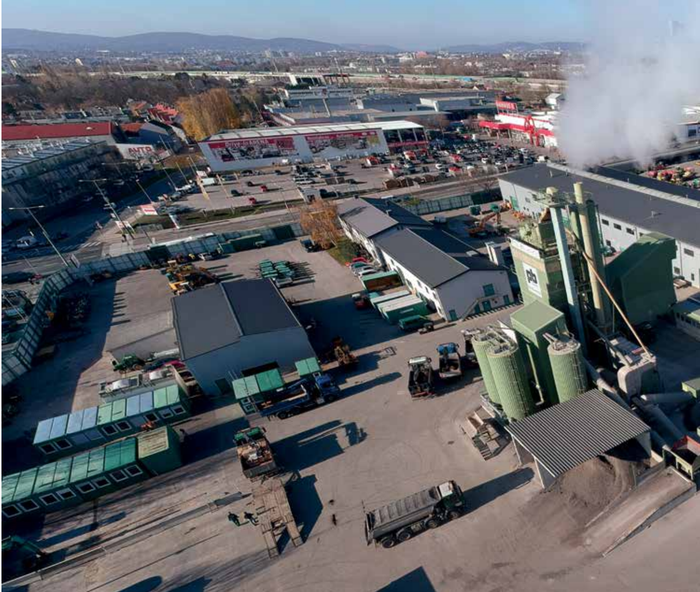
Zentralbauhof Wien-Inzersdorf, Asphaltmischanlage
