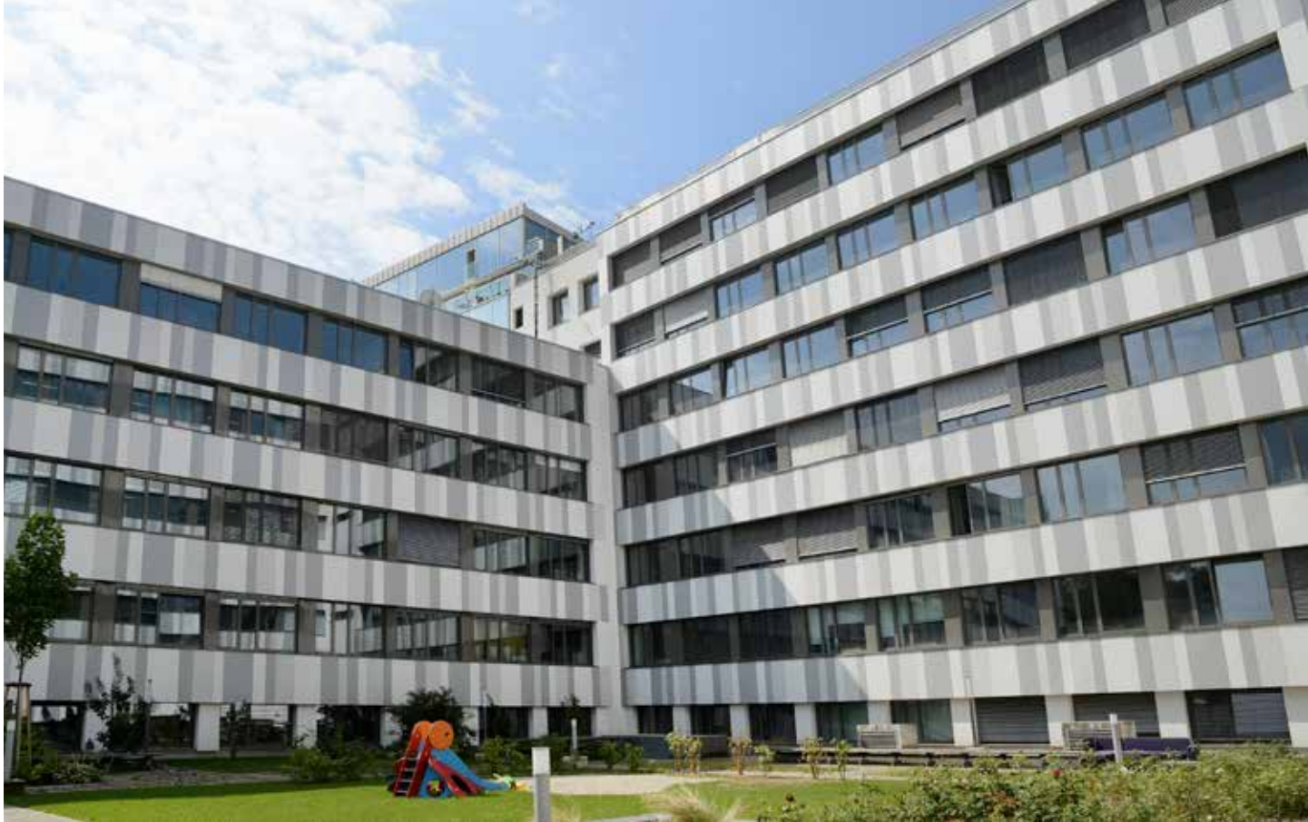
Technische Universität, Thermische Sanierung, Wien
