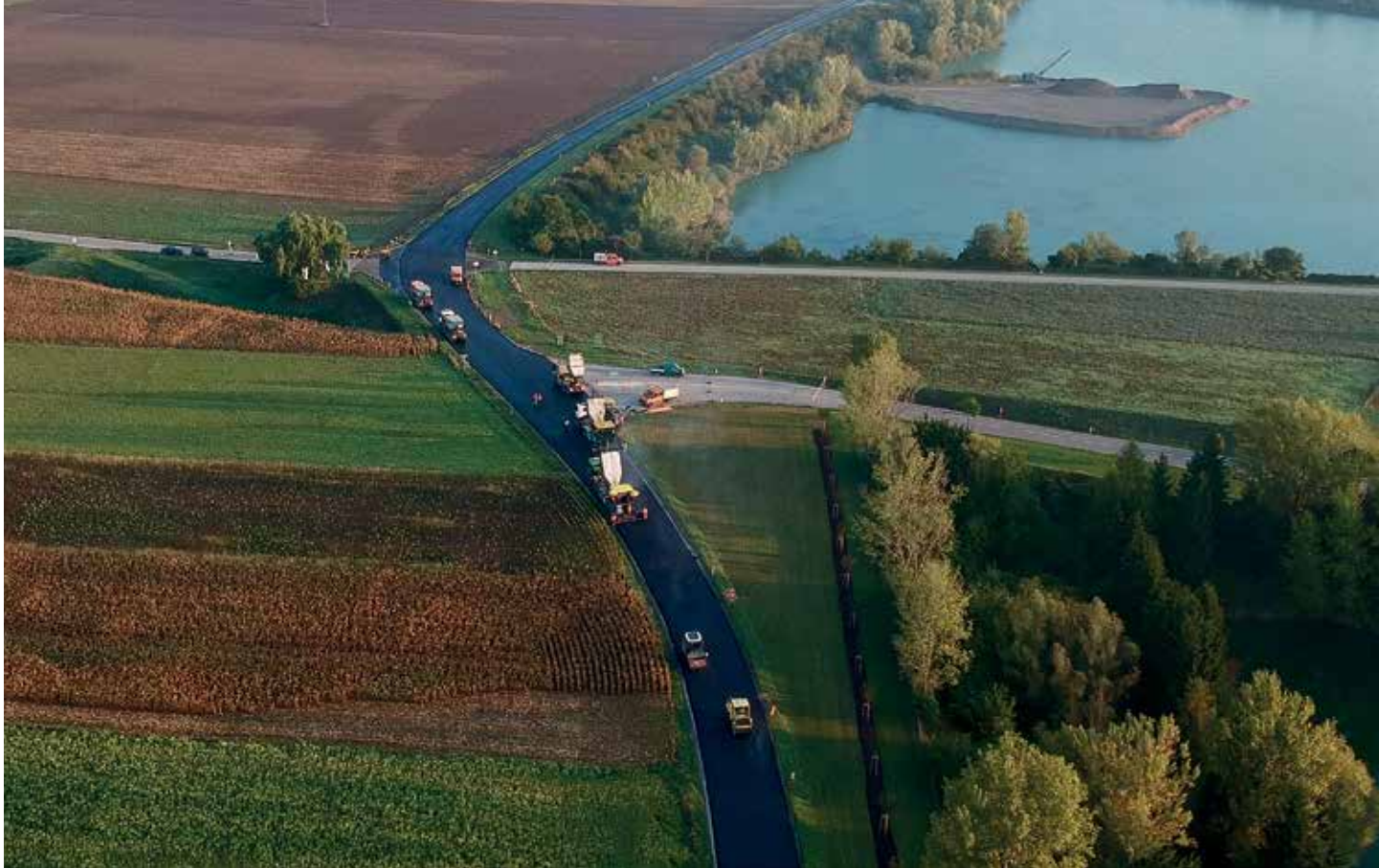
L113 Traismauer Süd, Niederösterreich
