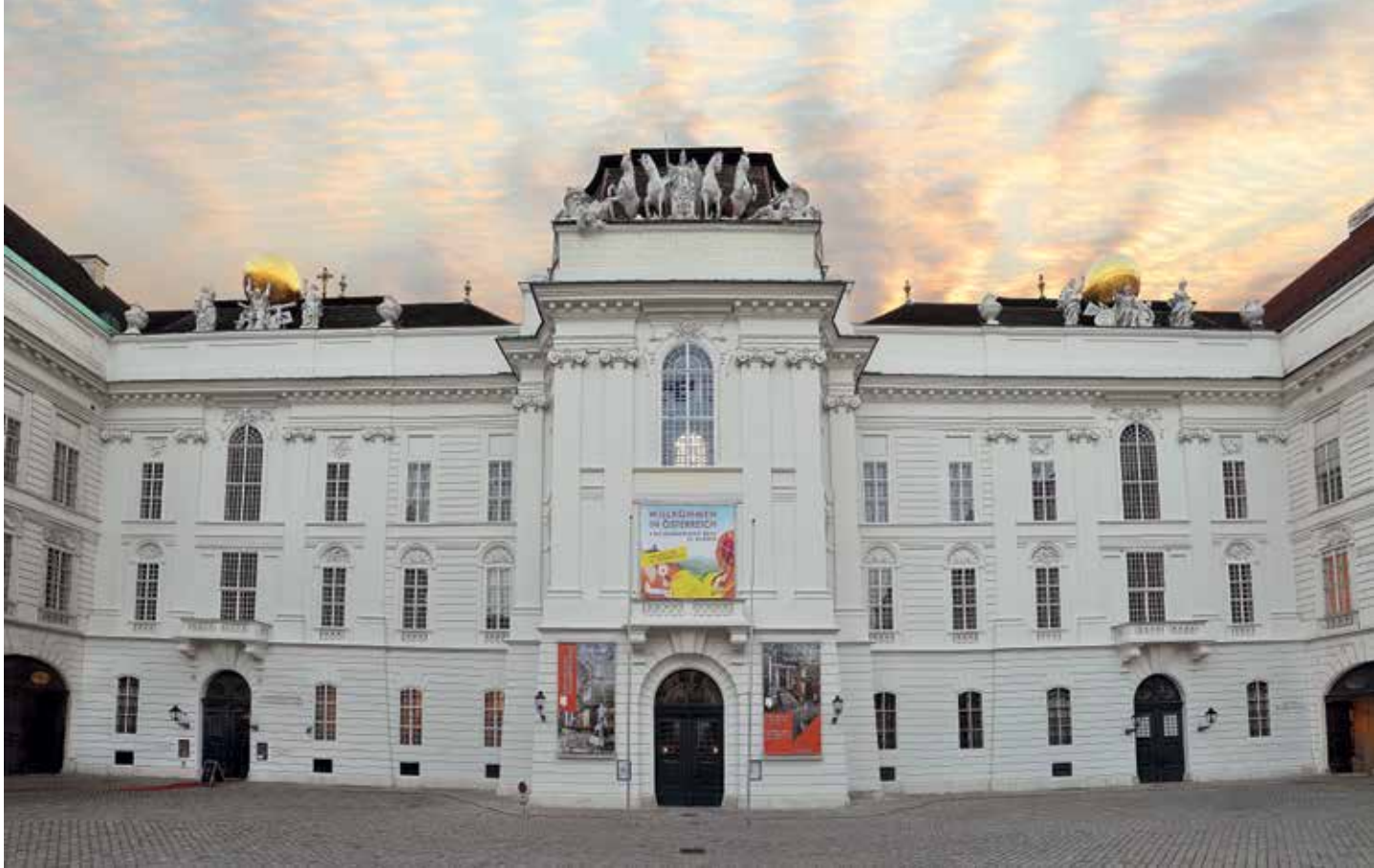
Österreichische Nationalbibliothek, Fassadensanierung, Wien
