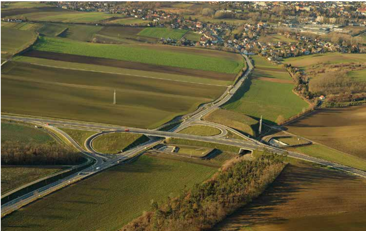
Umfahrung Mistelbach, Niederösterreich
