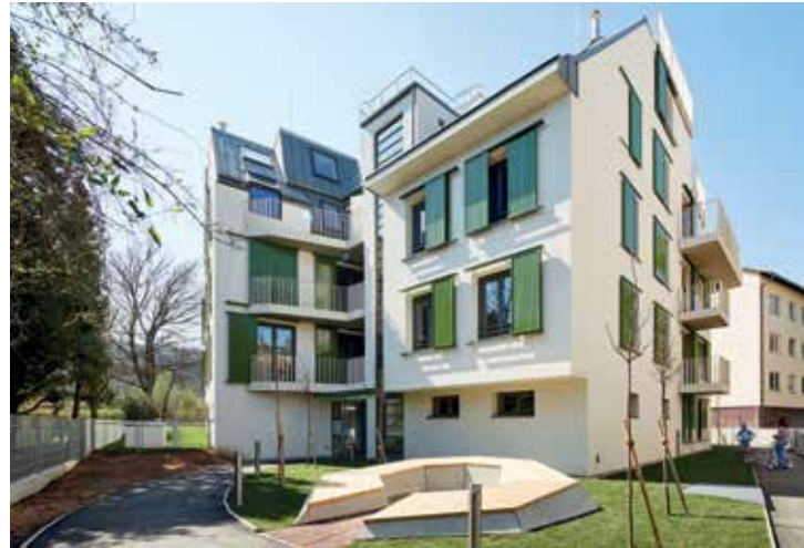
Wohnhausanlage Utendorfgasse, Wien
