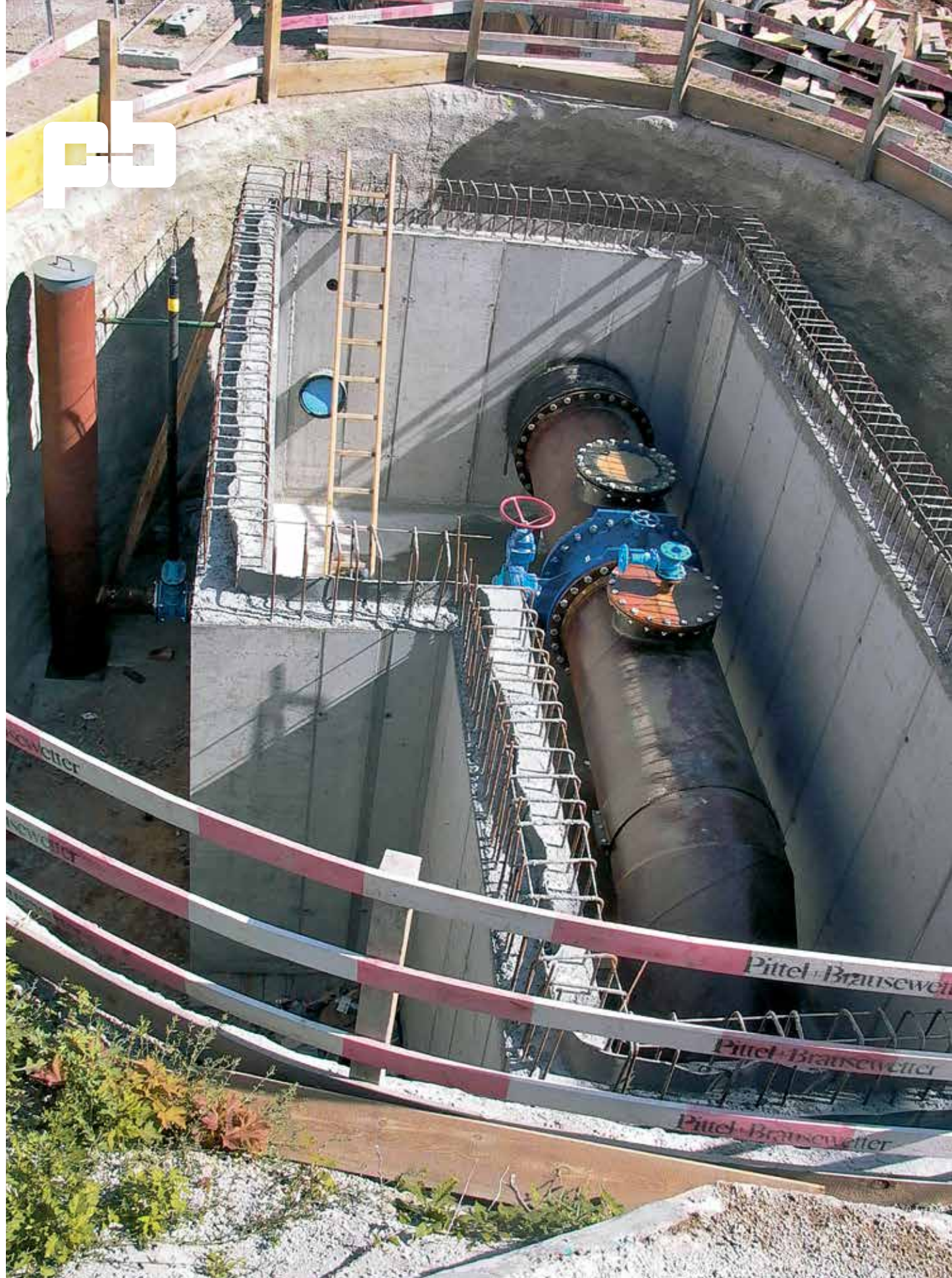
Wasser Schieberkammer, Grillgasse, Wien
