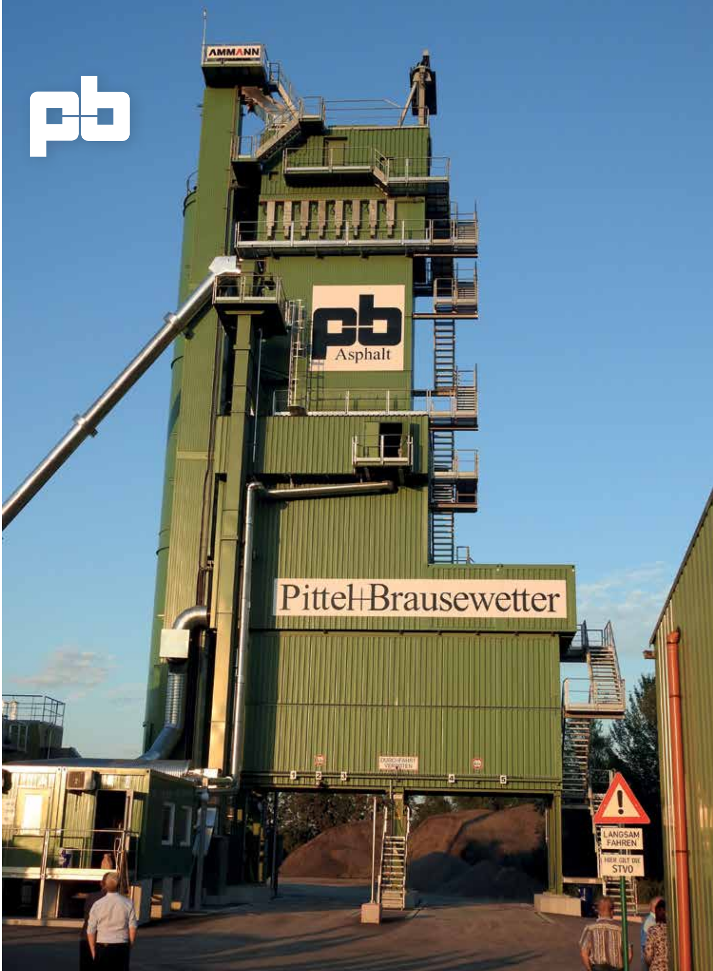
Heißmischanlage Tulln-Nitzing, Niederösterreich
