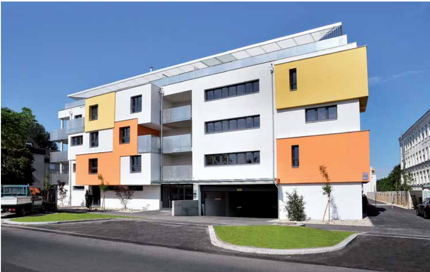
Wohnhausanlage Hardeggasse, Wien
