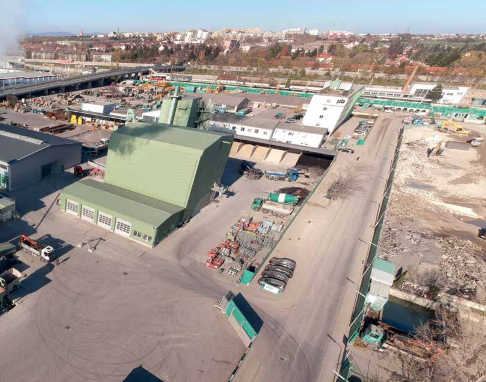
Zentralbauhof Wien-Inzersdorf, Betonmischanlage
