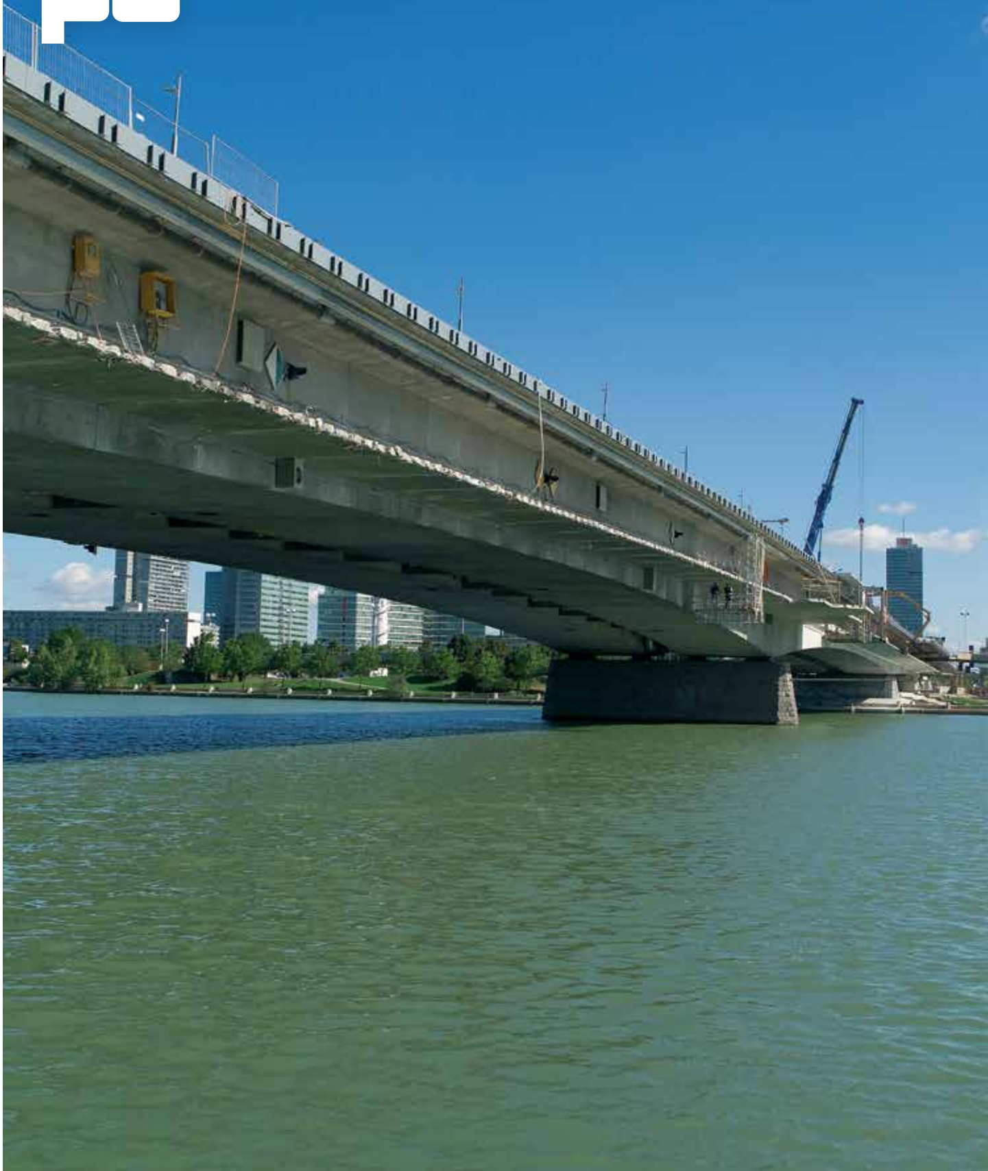
Reichsbrücke Wien, Sanierung
