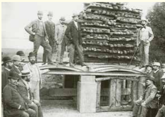
Probebelastung eines Stampfbetonbogens für die Kanalisation in Preßburg Stress test on a tamped concrete arch - Bratislava's sewerage.
