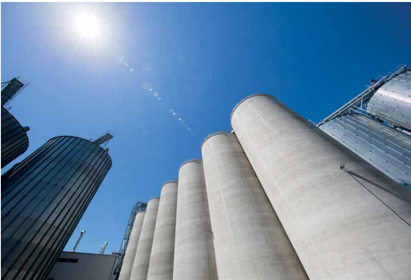
RWA Silos Aschach, Oberösterreich
