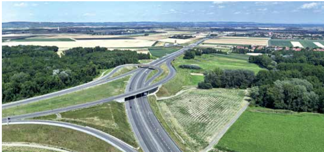
S33 Donaubrücke Traismauer - Rampe Nord, Niederösterreich
