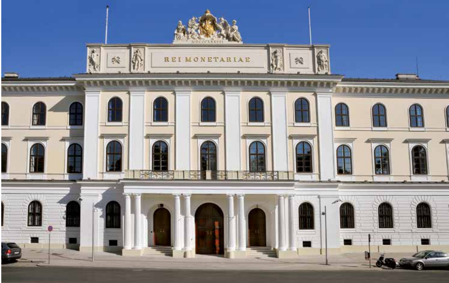
Münze Wien, Fassadensanierung, Wien
