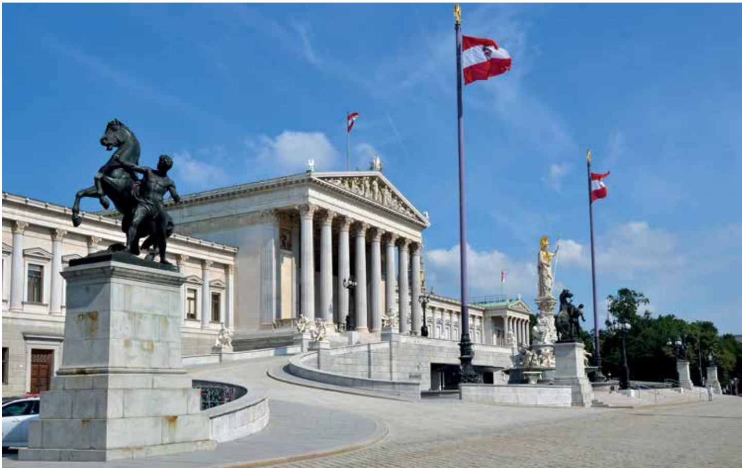
Generalsanierung Parlament, Wien
